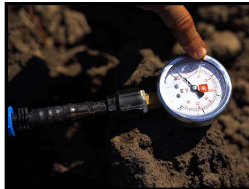
Fotografía 1: Manómetro midiendo presión en la lateral de riego
